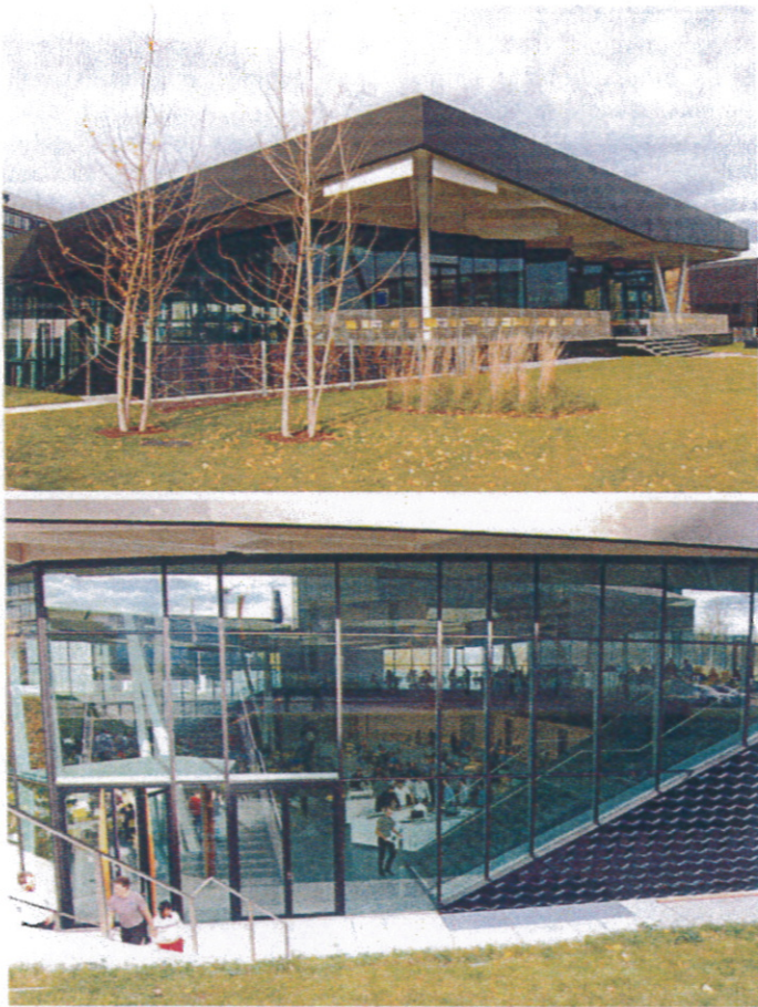
Ein- und Ausblicke: Obwohl das neue Gebäude vier Meter unter Bodenniveau errichtet wurde, lassen die weiten Fensterfronten viel Tageslicht hinein.
